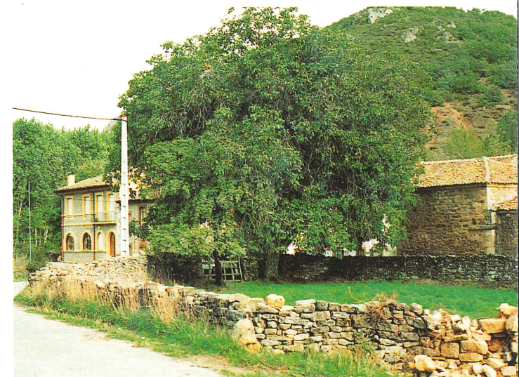
Vista del Balneario
